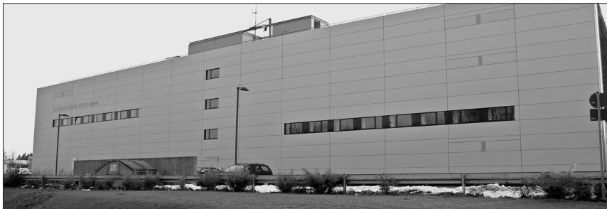
Nordansicht (Zugang zu Künstlergarderoben, Lager und Personalraum)
