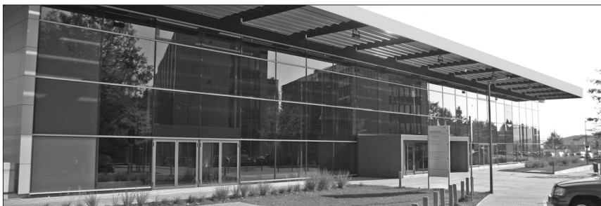
Südansicht (Direkter Zugang zur Galerie)
