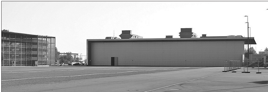
Westansicht (Lieferanteneingang, Zugang zum Messefreigelände)
