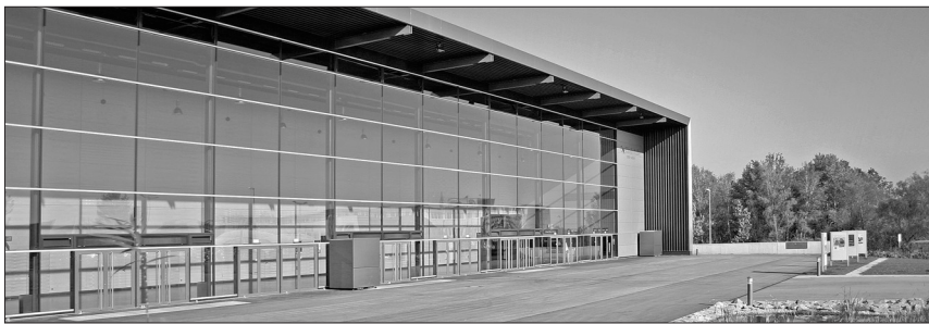
Ostansicht (Haupteingang, Zugang zum Hauptfoyer)
